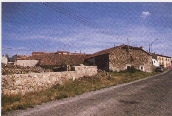
Cubierta con piñón y falda. Torrecaballeros.
