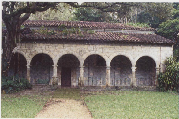
Arcada de la galería superior del claustro, hoy dispuesta al costado de Poniente del refectorio.
