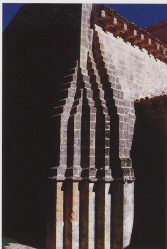
Detalle del contrafuerte en el ángulo noroeste del crucero.
