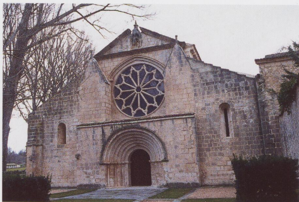
Fachada principal de la iglesia, hacia Poniente.
