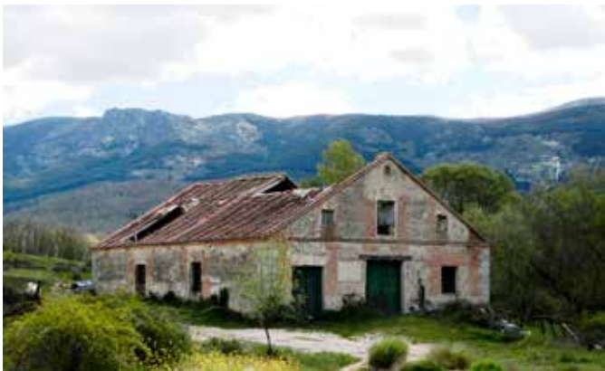
Edificio de la máquina de raspamento
