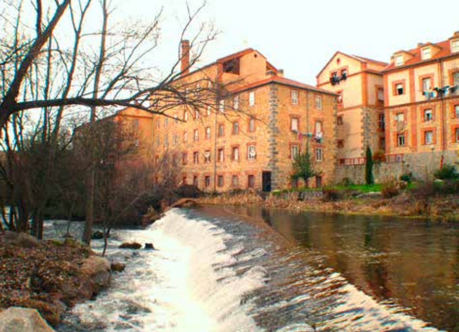
Azud y Fábrica de Harinas de Carretero reconvertida en viviendas
