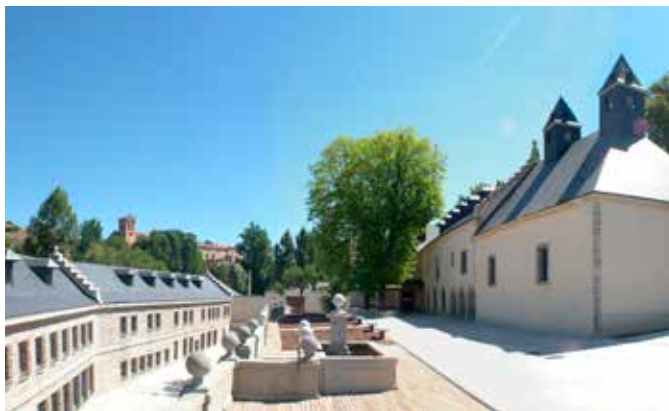
Vista desde el patio alto de la Casa de Moneda. A la derecha la fundición y a la izquierda el edificio de máquinas
