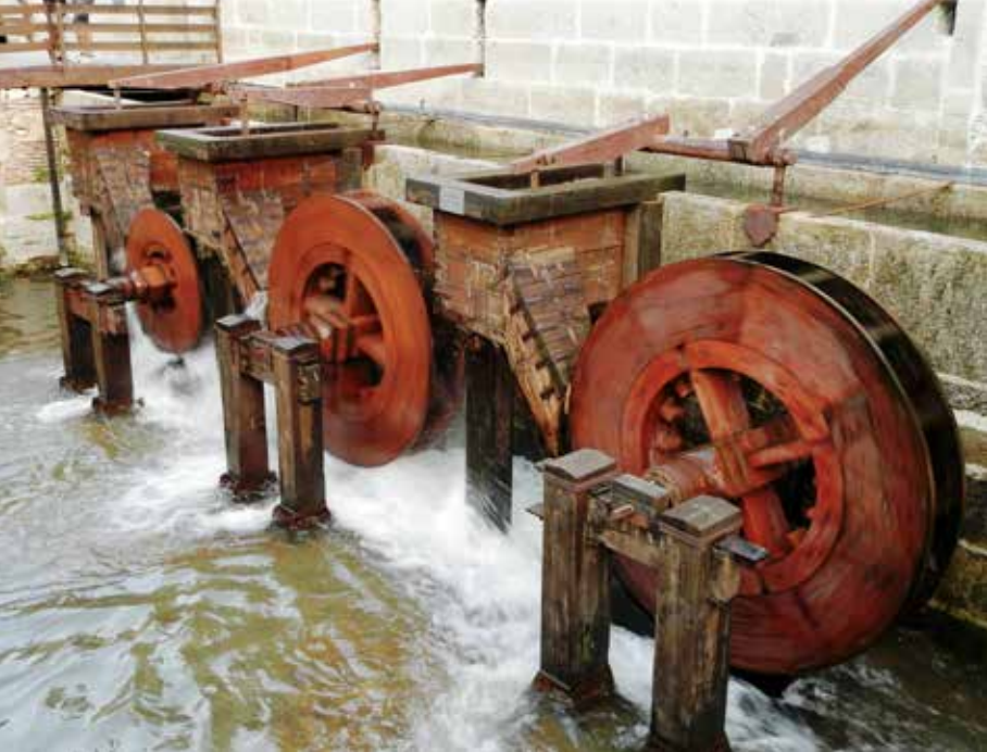
Reconstrucción de las tres ruedas hidráulicas de la herrería
