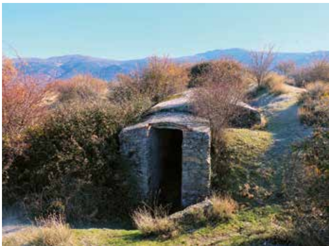
Entrada a uno de los abrigos contra intemperie para pelotón. Cruz de la Gallega.
