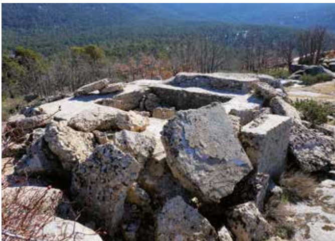
Abrigo blindado. Los bloques derrumbados son del blindaje de la cubierta, destruida en la posguerra para extraer los hierros del hormigón armado.
