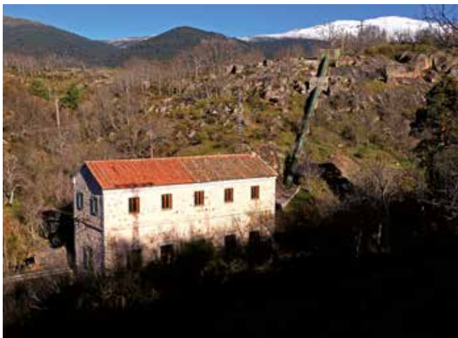
Fábrica de electricidad del Salto del Olvido, en Valsain, donde se produjeron los hechos.
