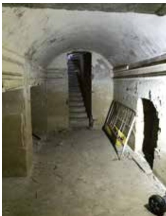
Interior del puesto de mando. Posición Cementerio
