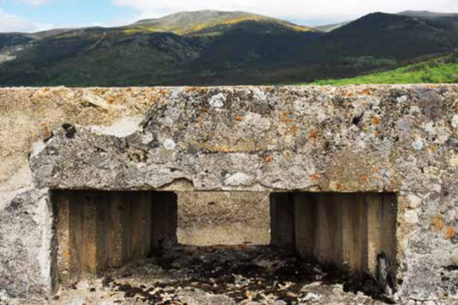
Fortín I. Troneras escalonadas
