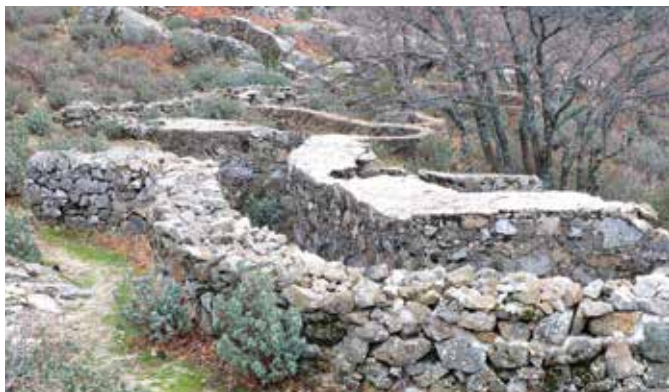
Parapeto o muro aspillerado del Cerro del Puerco.
