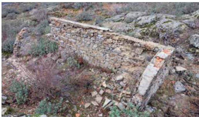
Restos de vivienda para pelotón construida con cubierta de cáscara y forma de media bóveda.
