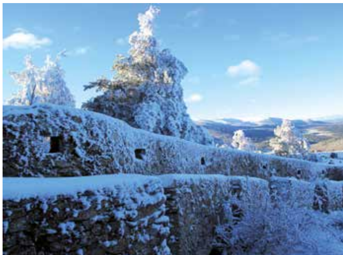
Muro aspillero o parapeto en la «Avanzadilla de la Cruz de la Gallega»
