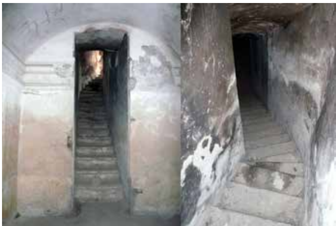
Interior y escalera de acceso al observatorio
