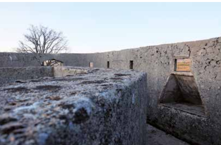
Fortín I. Interior. Emplazamiento para una de las ametralladoras
